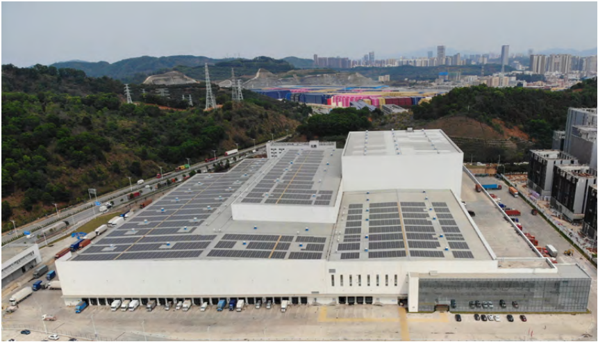
▲ 物流运营中心屋面光伏发电
